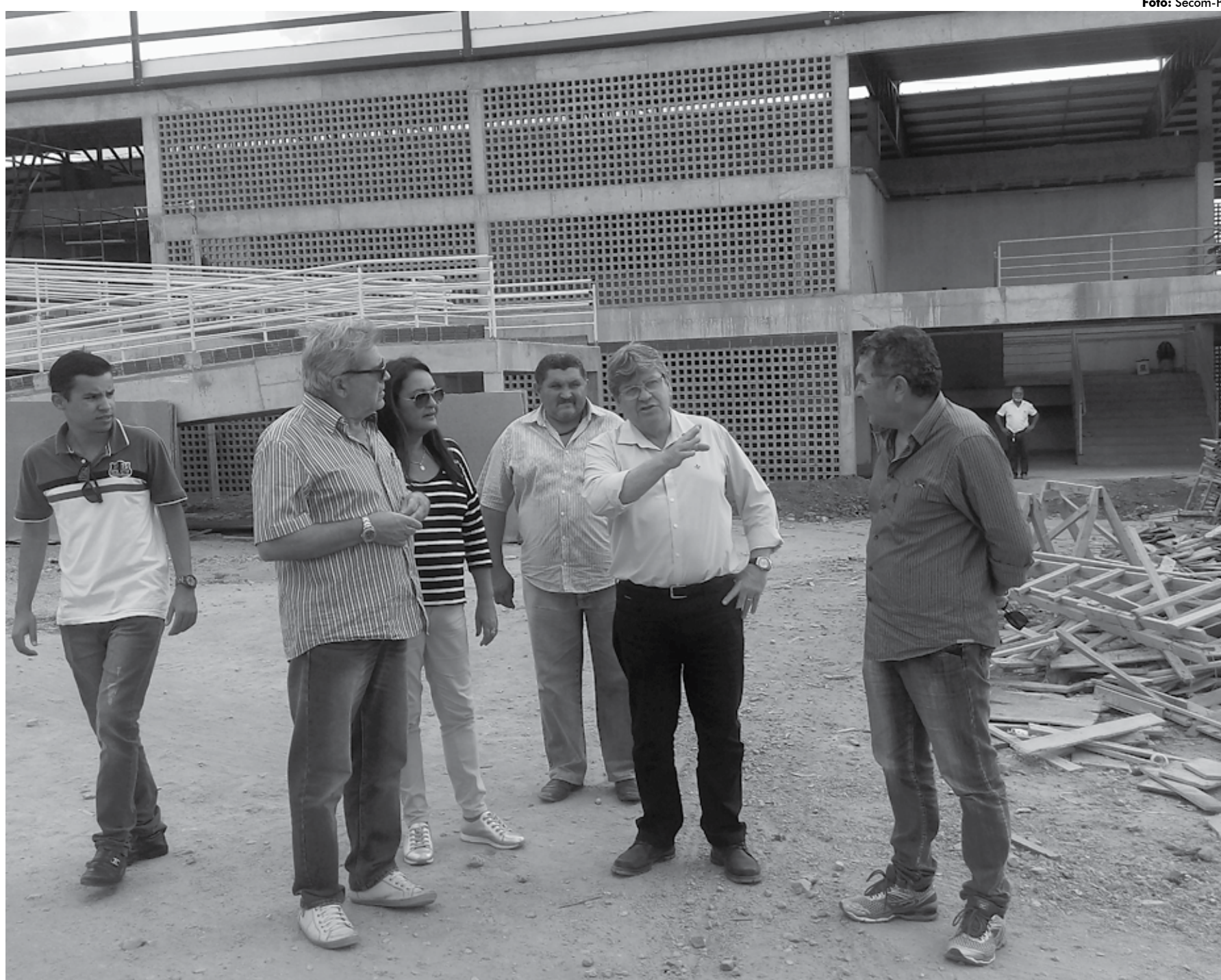
O secretário de Estado da Infraestrutura, Recursos Hídricos, Meio Ambiente, Ciência e Tecnologia, João Azevêdo, inspecionou obras nas cidades de Santo André, Serra Branca e Monteiro
